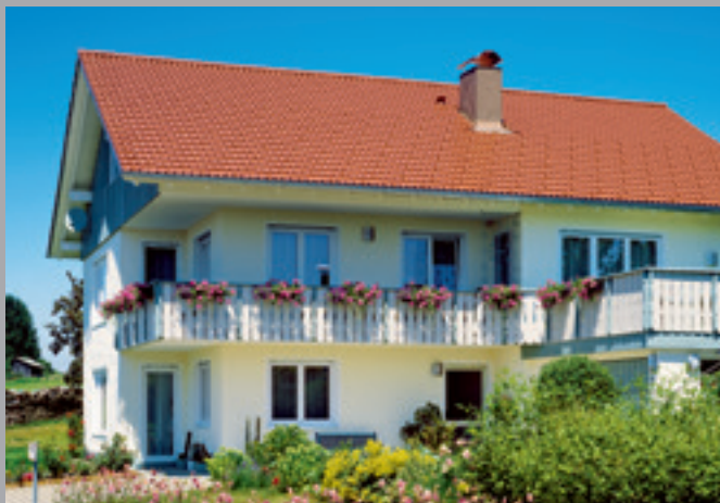
Wykończenie dachówką boczną lewą z deską szczytową*
