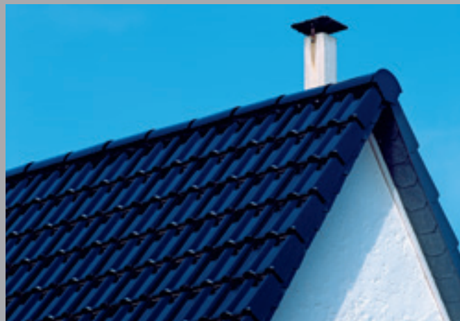
Wykończenie dachówką boczną prawą z deską szczytową*
